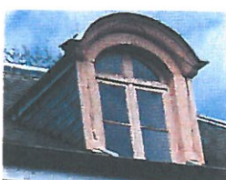
Lucarne demi-ronde charpentée
