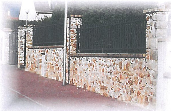
Mur en pierre et chaperon en petite tuile
