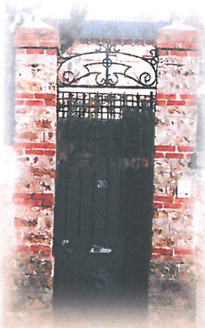
Clôture d'une maison bourgeoise. Les piliers déclinent les matériaux et le décor de la maison
